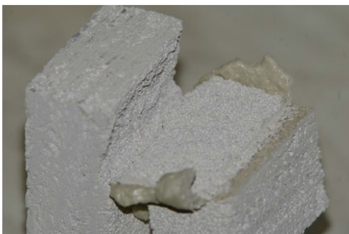
Рис. 8 Отделение ячеистого бетона во время испытания
